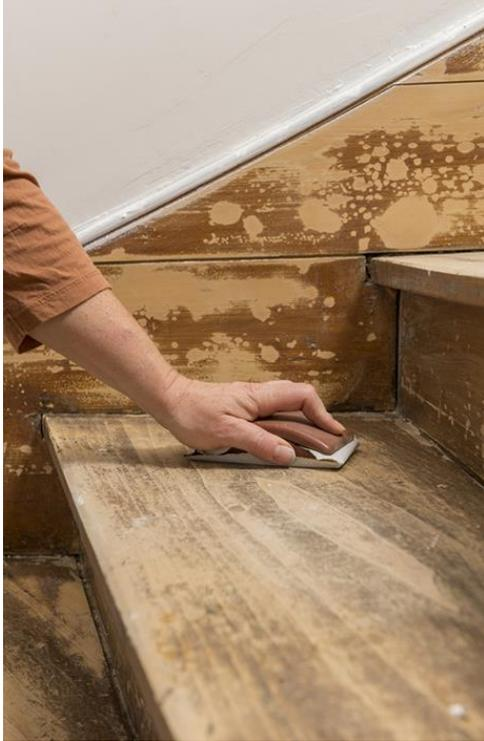
Une fois vos escaliers secs, rebouchez les fentes et les joints, et égrenez-les avec du papier de verre fin (180) de manière à retirer les fines couches de vernis restantes et à permettre une meilleure adhérence. Un ponçage à blanc de la surface n'est pas nécessaire.
