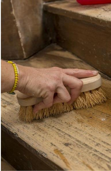
Afin d'éliminer tout résidu graisseux qui altéreraient l'application de la peinture, commencez par lessiver les escaliers avec un dégraissant concentré à base de soude ([Solarine](#), Saint Marc).
